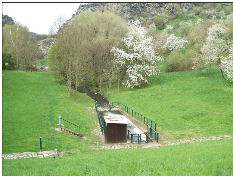
Obr.C.5.1 – Pohled na vývar VD Džbán (pohled po vodě)
