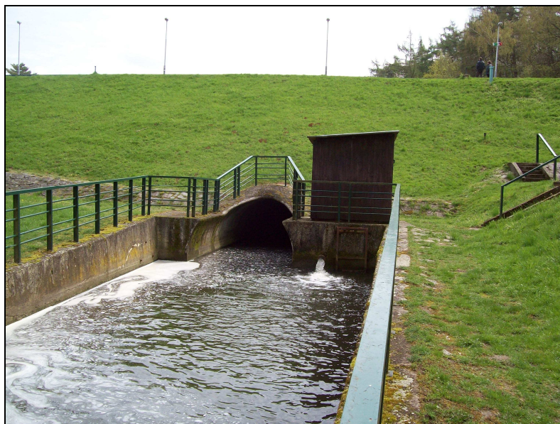
Obr.C.5.2 – Pohled na vývar VD Džbán (pohled proti vodě)
