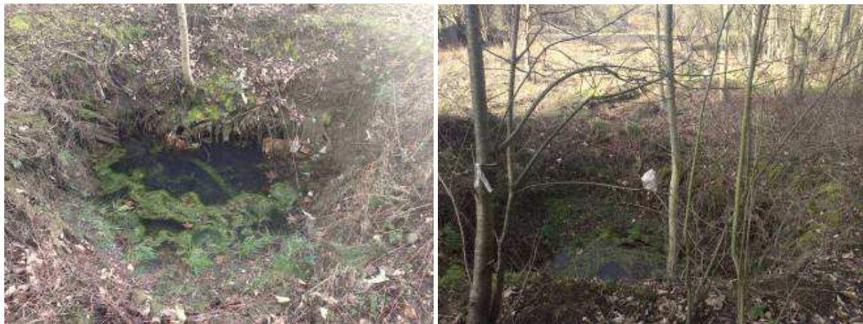
Obr. C.6.7 Vyústění odlehčovací stoky DN 2000 od OK3D Evropská
